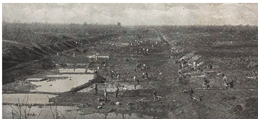
RAVENNA — Scavazione dei canali animatori della bocca di Porto Corsini
