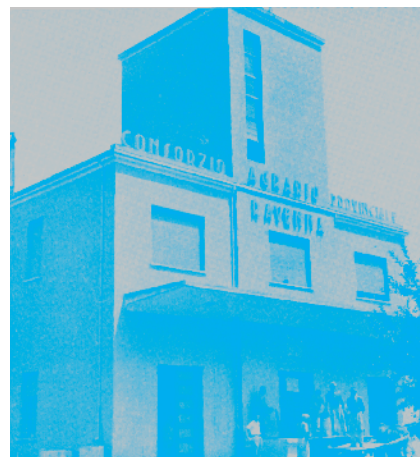
Magazzini granai del Consorzio di Ravenna.
